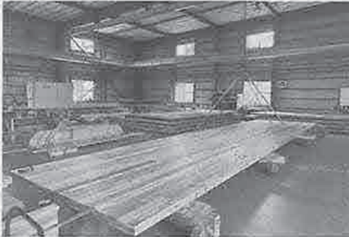
同社工場で加工中のCLT大盤
