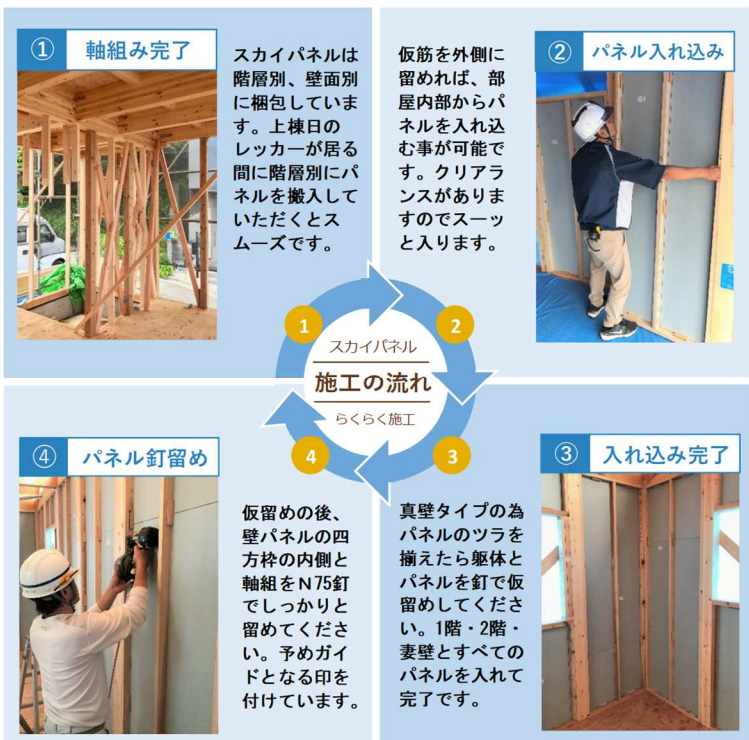
【図2:スカイパネル施工の流れ】
